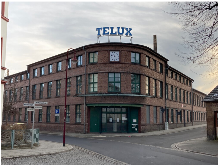
Spitze Ecke" der "Neuen Oberlausitzer Glashüttenwerke", Ansicht von Nordwesten Fotograf/Urheber: Kathrin Krüner
