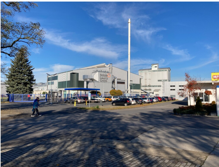
Produktionshallen der Glaswerke "Stölzle - Oberglas Lausitz GmbH Fotograf/Urheber: Nora Wiedemann
