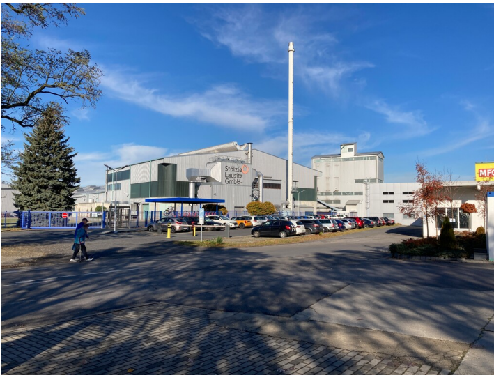
Produktionshallen der Glaswerke "Stölzle - Oberglas Lausitz GmbH Fotograf/Urheber: Nora Wiedemann
