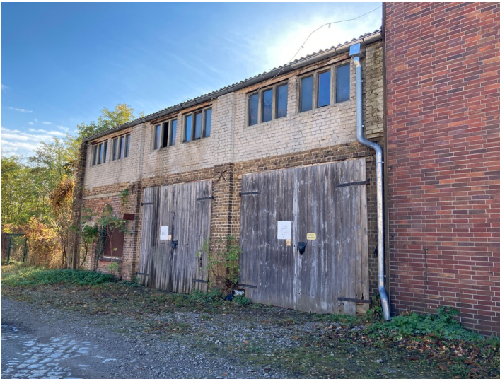
Reste der Produktionshalle der "Doktorhütte", Ansicht von Nordwesten Fotograf/Urheber: Kathrin Kruner
