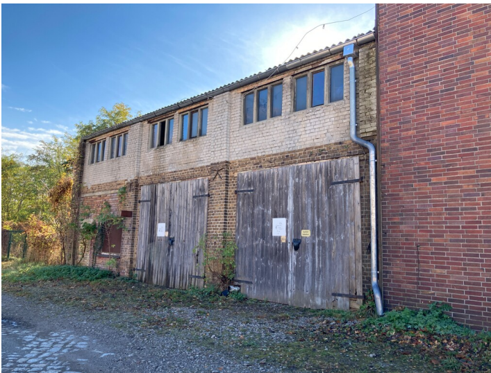
Reste der Produktionshalle der "Doktorhütte", Ansicht von Nordwesten Fotograf/Urheber: Kathrin Kruner
