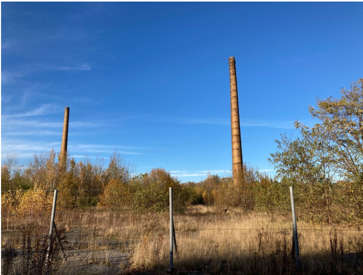
Bärenhütte, Blick auf Fabrikgelände vom Neuteichweg Fotograf/Urheber: Kathrin Krüner
