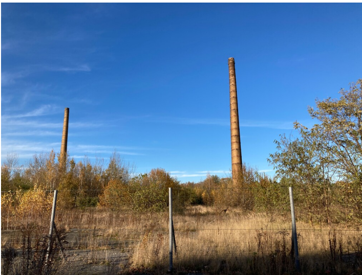
Bärenhütte, Blick auf Fabrikgelände vom Neuteichweg Fotograf/Urheber: Kathrin Krüner
