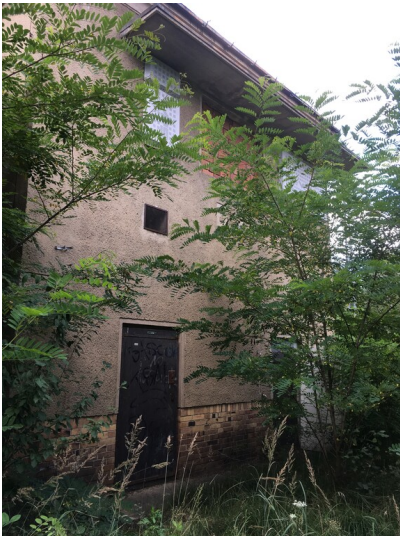
Stellwerk der Kohleringbahn, Straßenansicht von Südosten Fotograf/Urheber: Kathrin Kruner
