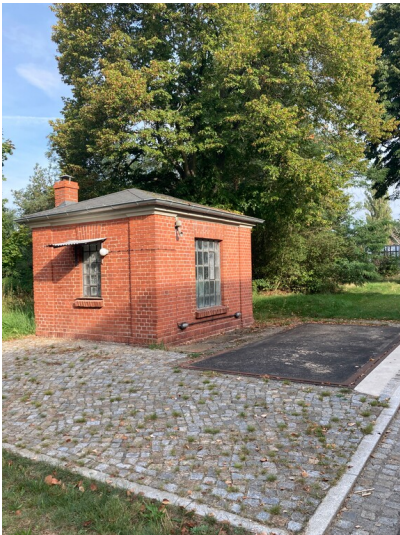
Landabsatzwaage der Brikettfabrik Knappenrode, Ansicht von Südosten Fotograf/Urheber: Kathrin Kruner
