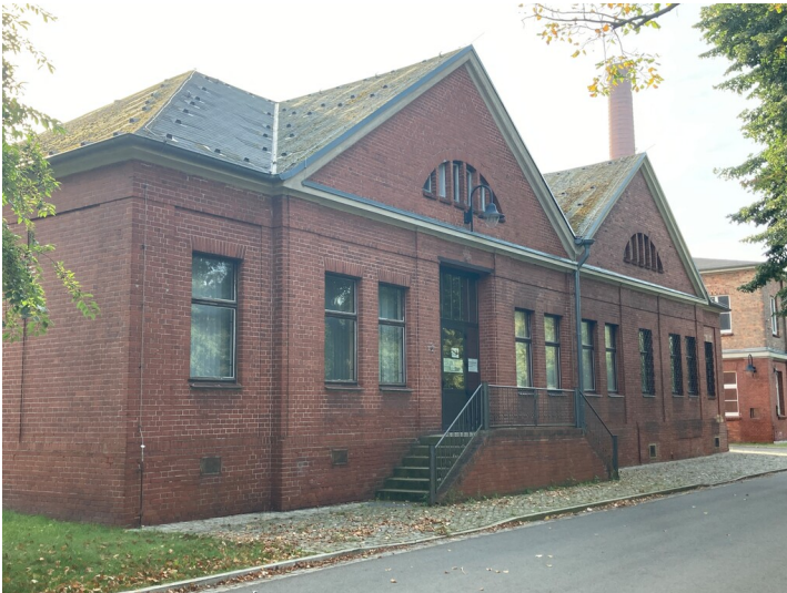
Verwaltungsgebäude Brikettfabrik Knappenrode, Straßenansicht von Nordwesten Fotograf/Urheber: Kathrin Kruner
