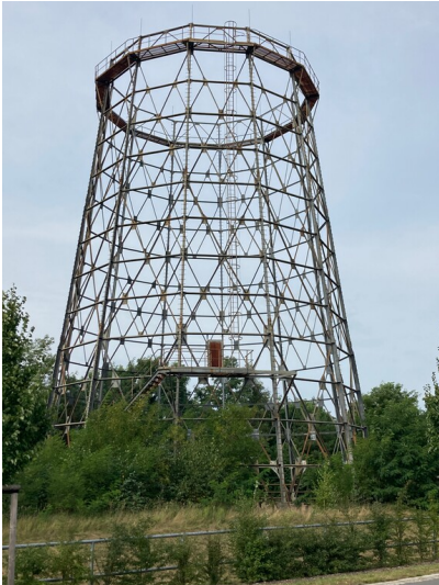
Kühlturmgerüst der Brikettfabrik Knappenrode, Ansicht von Nordosten Fotograf/Urheber: Kathrin Kruner
