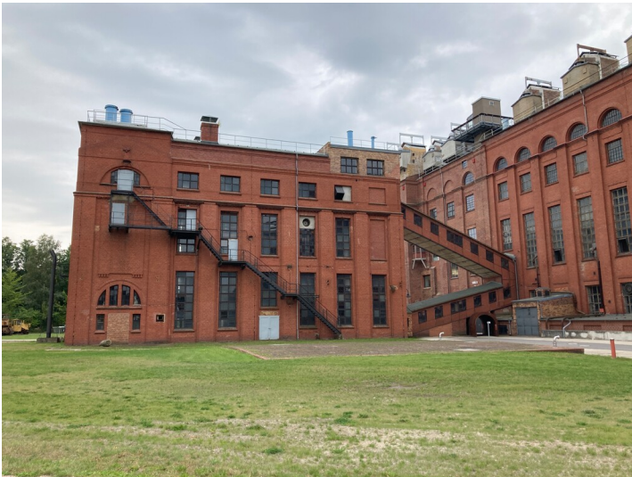
Kühlhaus I der Brikettfabrik Knappenrode; Ansicht von Norden Fotograf/Urheber: Kathrin Krüner
