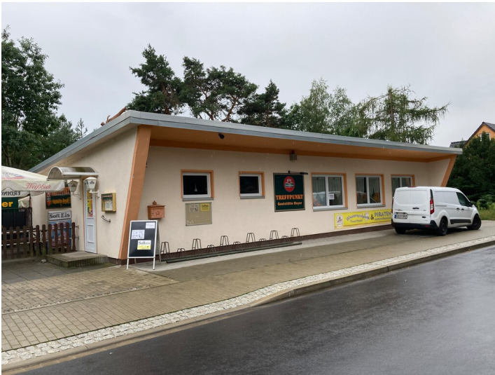
Gasthaus Friedrich-Ebert-Str., Ansicht von Nordosten Fotograf/Urheber: Matin Neubacher
