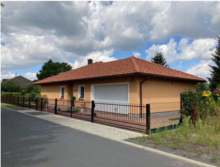
Einfamilienwohnhaus Friedrich-Ebert-Str. 14, Ansicht von Süden Fotograf/Urheber: Matin Neubacher
