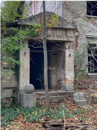
Verwaltungsgebäude Gelsdorfhütte, Detailansicht Eingangsbereich Fotograf/Urheber: Kathrin Kruner
