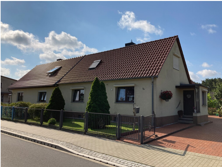
Doppelwohnhaus Friedrich-Ebert-Str. 7, Straßenansicht Fotograf/Urheber: Martin Neubacher
