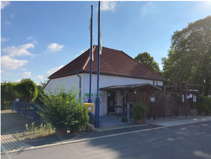
Laden, ehem. Spritzenhaus, Friedrich-Ebert-Str. 2, Ansicht von Süden Fotograf/Urheber: Matin Neubacher
