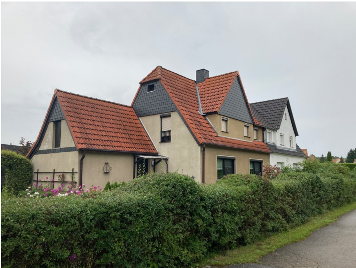
Werkssiedlung Knappenrode Fotograf/Urheber: Matin Neubacher
