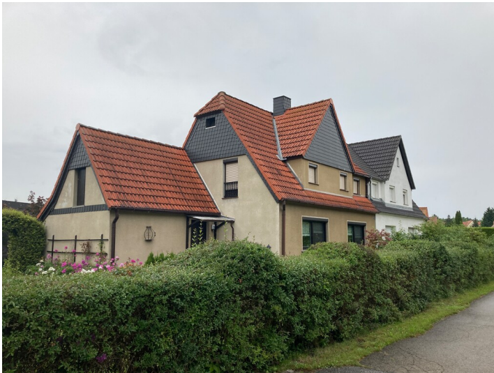
Doppelwohnhaus Am Hochwald 2, Ansicht von Norden Fotograf/Urheber: Matin Neubacher
