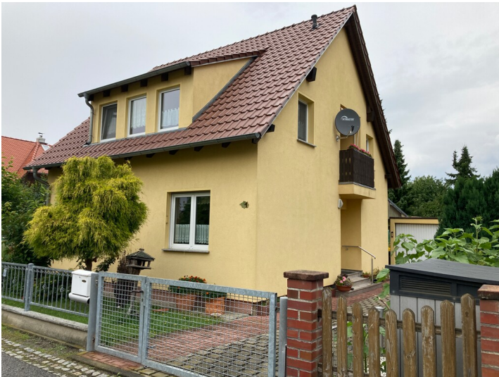
Einfamilienwohnhaus Am Hochwald 1, Ansicht von Süden Fotograf/Urheber: Matin Neubacher
