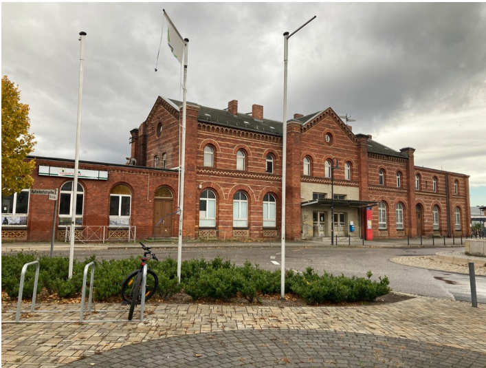
Bahnhof Weißwasser, Frontalansicht von Nordosten Fotograf/Urheber: Kathrin Krüner
