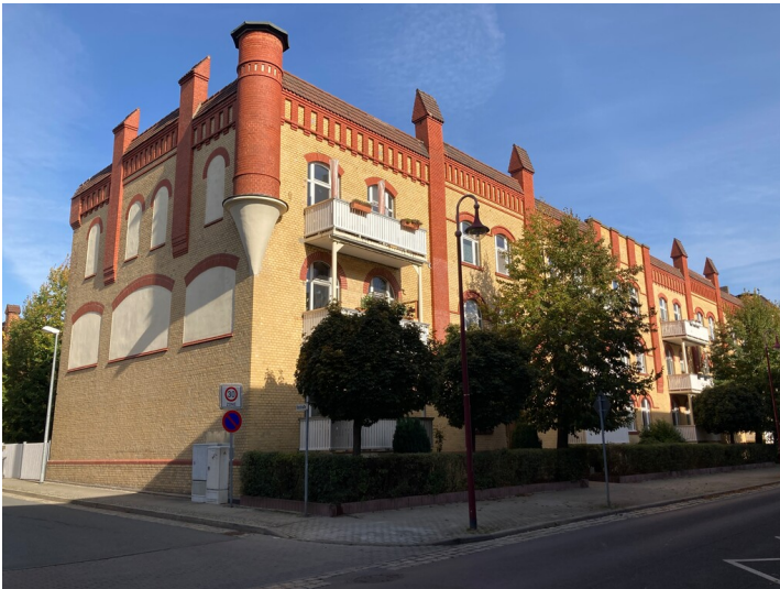
Werkssiedlung Neue Oberlausitzer Glashüttenwerke, Ansicht Straße der Einheit 17 von Osten Fotograf/Urheber: Kathrin Kruner
