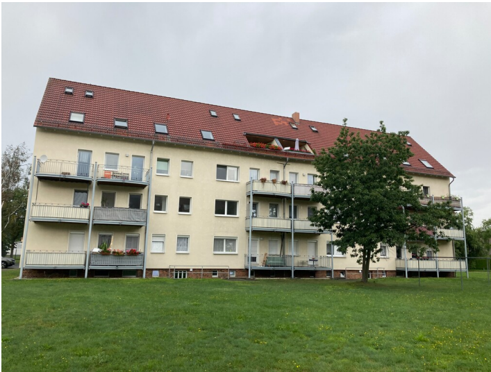
Mehrfamilienhaus Karl-Marx-Straße 6, Ansicht von Südosten Fotograf/Urheber: Matin Neubacher
