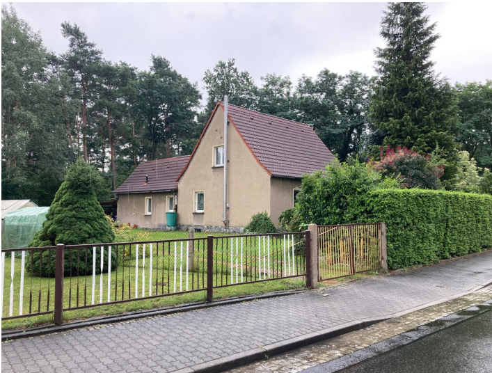
Einfamilienwohnhaus Karl-Marx-Str. 15, Ansicht von Westen Fotograf/Urheber: Matin Neubacher
