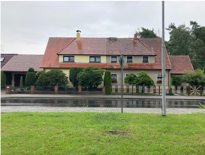
Doppelwohnhaus Karl-Marx-Str. 13, Ansicht von Westen Fotograf/Urheber: Matin Neubacher
