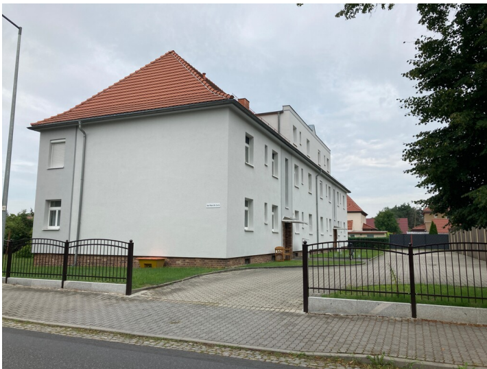
Wohngebäude Karl-Marx-Str. 2a; 2b, Ansicht Osten Fotograf/Urheber: Matin Neubacher
