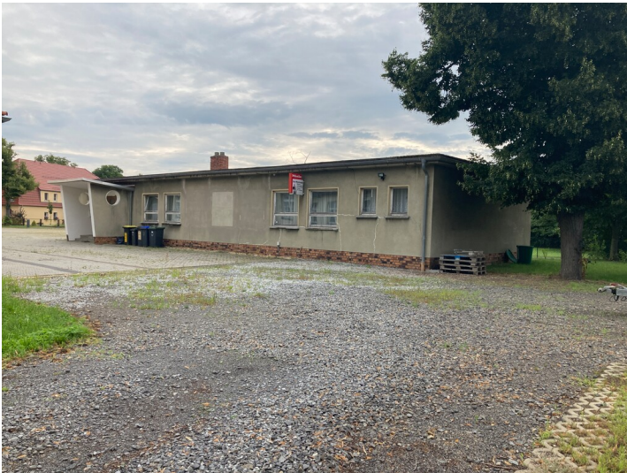
Ehem. Schulküche und Wäscherei der Werkssiedlung Knappenrode, Ansicht Südwesten Fotograf/Urheber: Matin Neubacher
