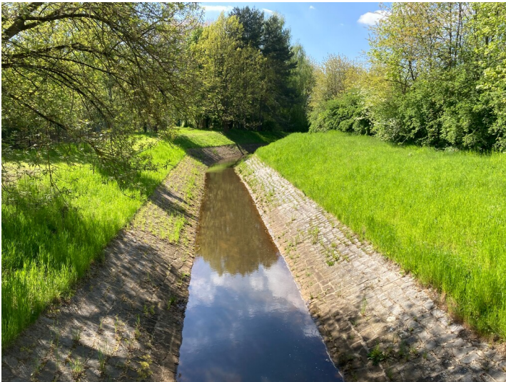
Mortkaer Graben Fotograf/Urheber: Nora Wiedemann
