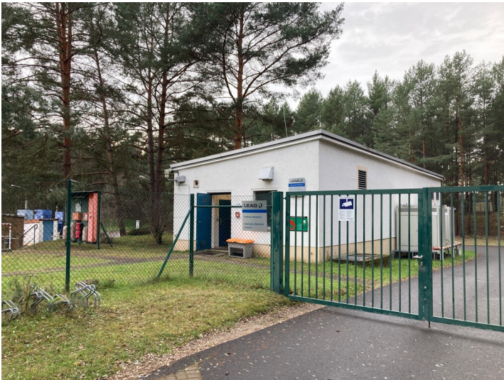
Einlaufbauwerk Schwarzer Schöps Fotograf/Urheber: Matin Neubacher
