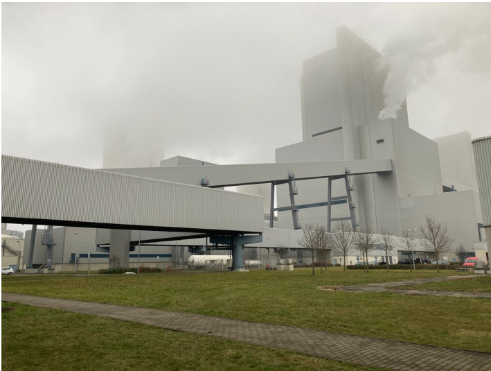
Kühlturmszusatzwasseraufbereitungsanlage Fotograf/Urheber: Nora Wiedemann
