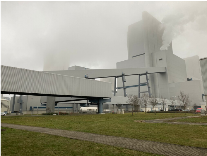
Kühlturmzusatzwasseraufbereitungsanlage Fotograf/Urheber: Nora Wiedemann
