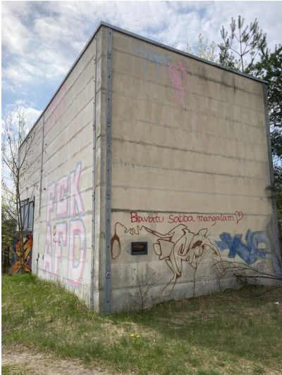
Wasserwerk Tagebau Scheibe Fotograf/Urheber: Nora Wiedemann
