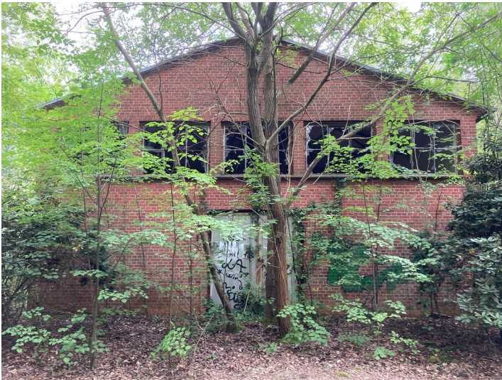
Pumpwerk des Tagebaus Glückauf (Werminghoff II) Fotograf/Urheber: Nora Wiedemann
