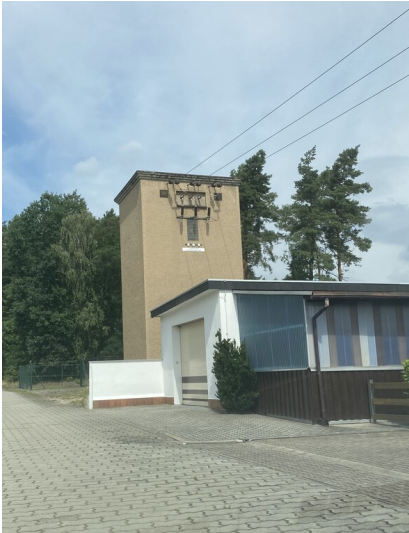
Transformatorenstation Torno Fotograf/Urheber: Nora Wiedemann
