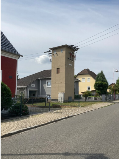
Transformatorenstation Leippe Fotograf/Urheber: Nora Wiedemann
