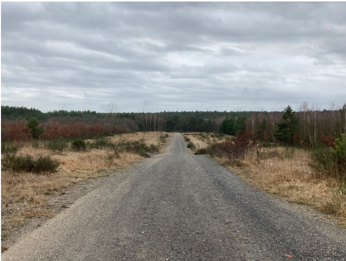
Wiederrichtete Wegeverbindung zwischen Nochten und Weißwasser/O.L. Fotograf/Urheber: Kathrin Krüner
