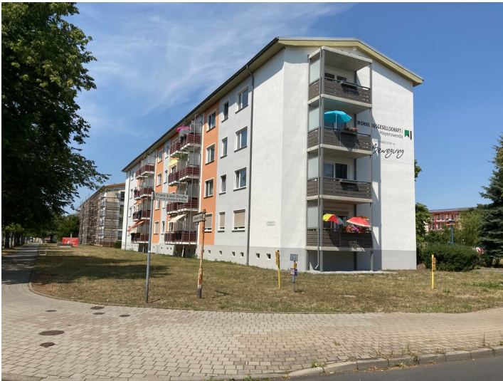
Wohnkomplex IV Fotograf/Urheber: Nora Wiedemann
