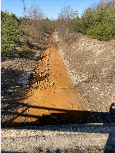
Lugteich - Restloch des Tagebaus Erika Überleiter zum Lugteich Fotograf/Urheber: Tom Pfefferkorn
