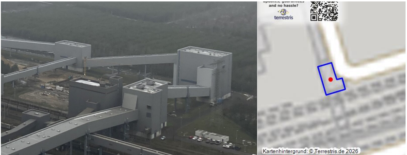
Bandspannturm Fotograf/Urheber: Ronald Heynowski
