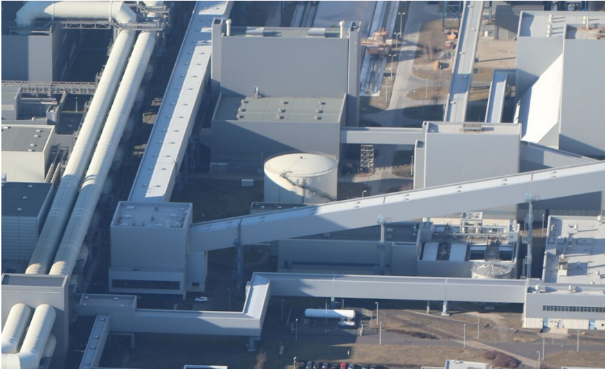
Heizölbehälter zum Anfahren des Kraftwerks Fotograf/Urheber: Ronald Heynowski
