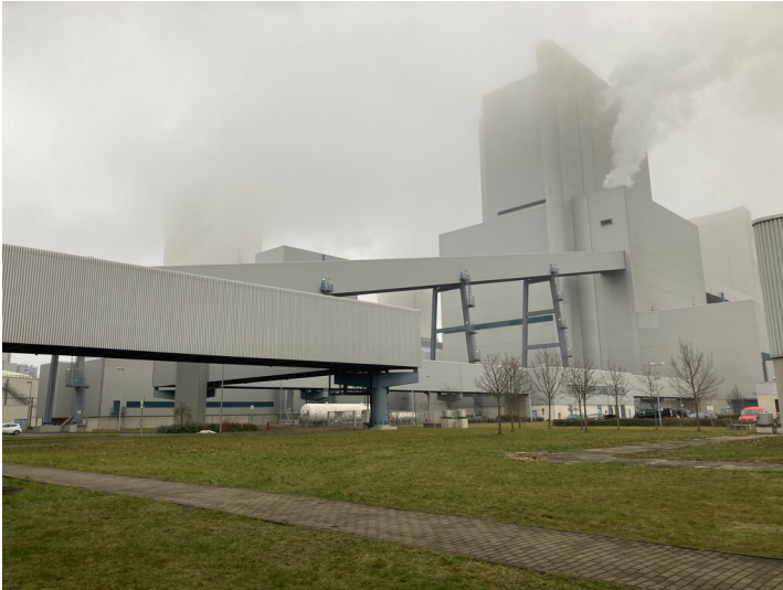
Kohlebandbrücken vor dem Bunkerschwerbau Fotograf/Urheber: Nora Wiedemann
