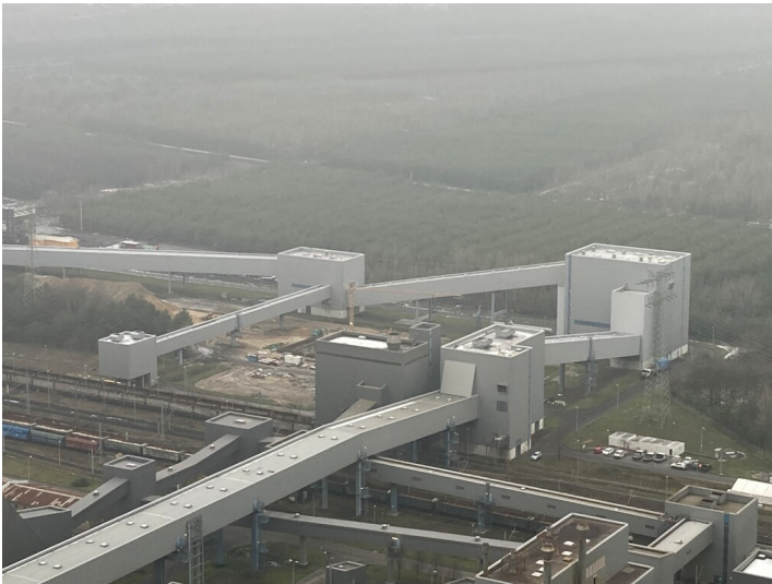
Brecherturm Fotograf/Urheber: Nora Wiedemann
