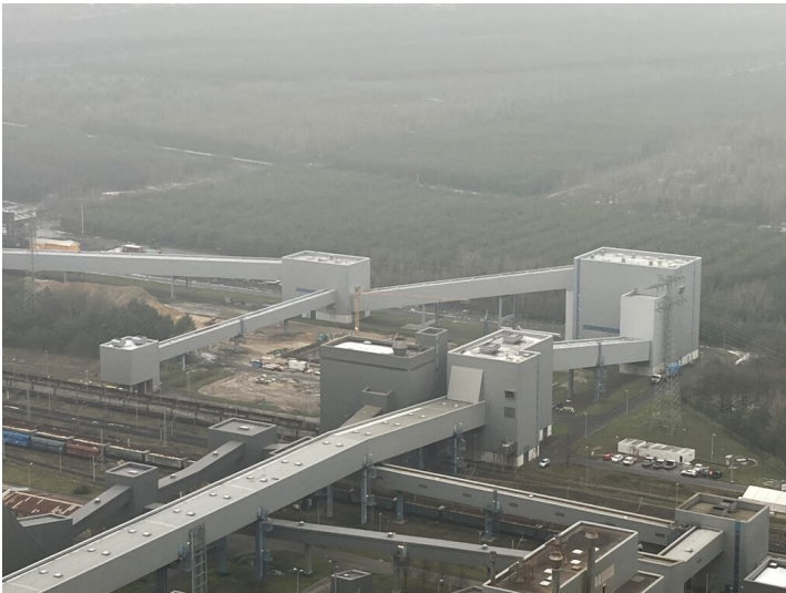
Brecherturm Fotograf/Urheber: Nora Wiedemann
