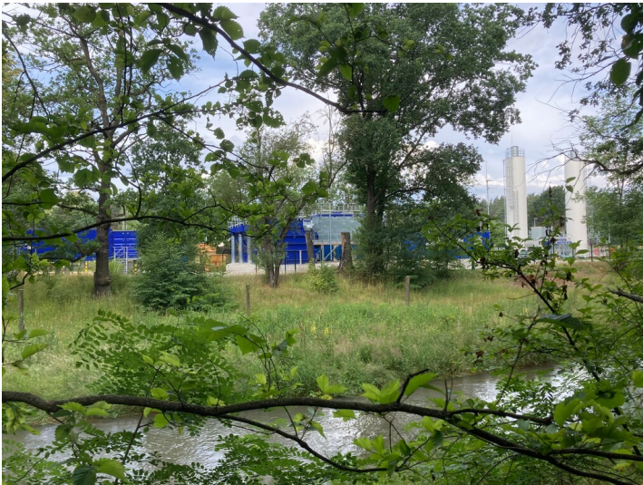
Modulare Wasserbehandlungsanlage Ruhlmühle Fotograf/Urheber: Nora Wiedemann
