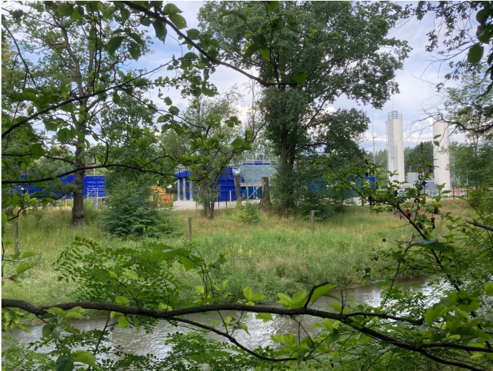
Modulare Wasserbehandlungsanlage Ruhlmühle Fotograf/Urheber: Nora Wiedemann
