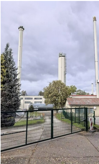
Braunkohlestaubkraftwerk zur Nahwärmeerzeugung Fotograf/Urheber: Nora Wiedemann
