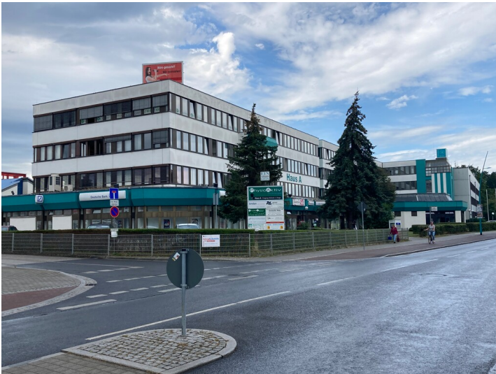
Hauptstandort des Bau- und Montagekombinats Kohle und Energie Fotograf/Urheber: Tom Pfefferkorn
