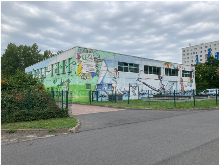
Spitzenkraftwerk WK I Fotograf/Urheber: Nora Wiedemann
