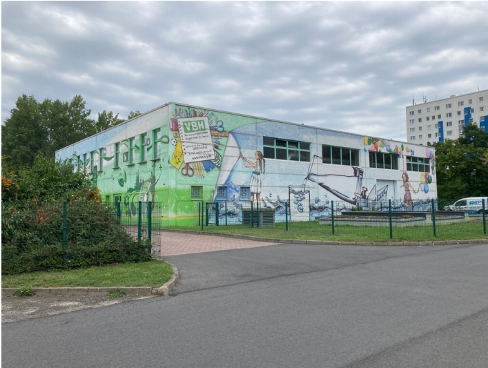
Spitzenkraftwerk WK I Fotograf/Urheber: Nora Wiedemann
