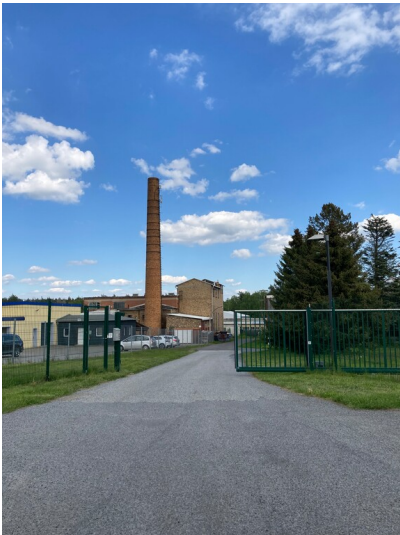
Industrieanlage am Tagebaurestsee Fotograf/Urheber: Nora Wiedemann
