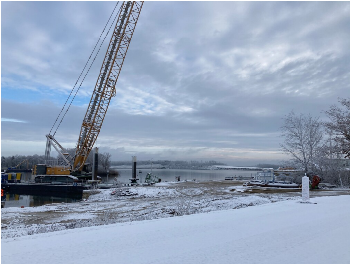
Blick von Süden auf den Knappensee. Im Vordergrund Sanierungsarbeiten der LMBV, im Hintergrund die Rutschung am Ostufer. Fotograf/Urheber: Nora Wiedemann
