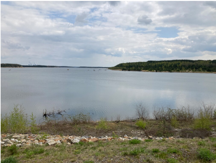
Speicherbecken Lohsa II Fotograf/Urheber: Kathrin Krüner
