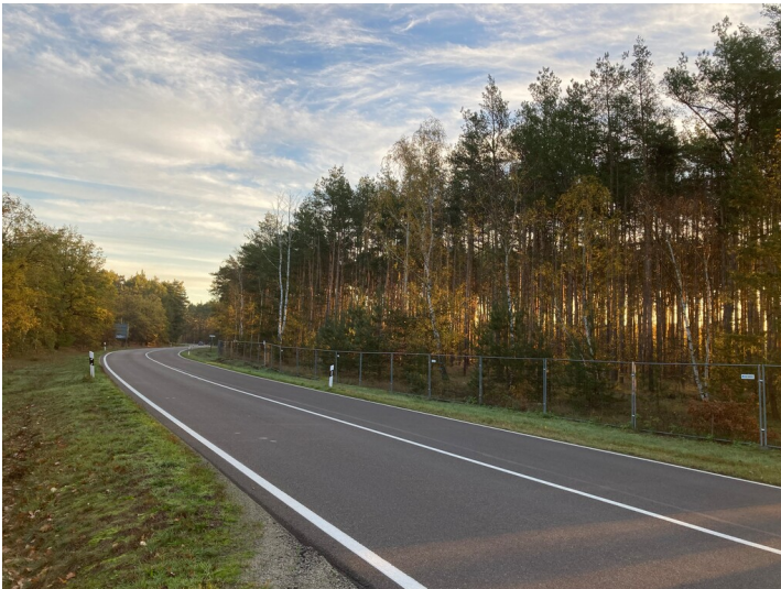
Umverlegung der Bundesstraße 96 um den Tagebau Werminghoff I Fotograf/Urheber: Nora Wiedemann
