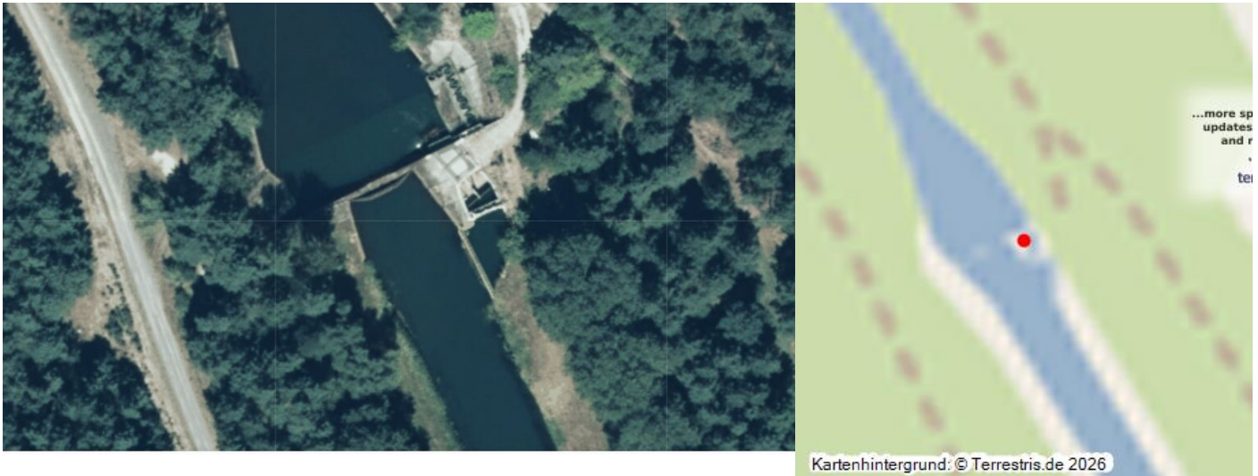
Überströmbares Flusskraftwerk Tzschelln - aktuelles Luftbild Sommer 2022 GeoSN Fotograf/Urheber: Nora Wiedemann
