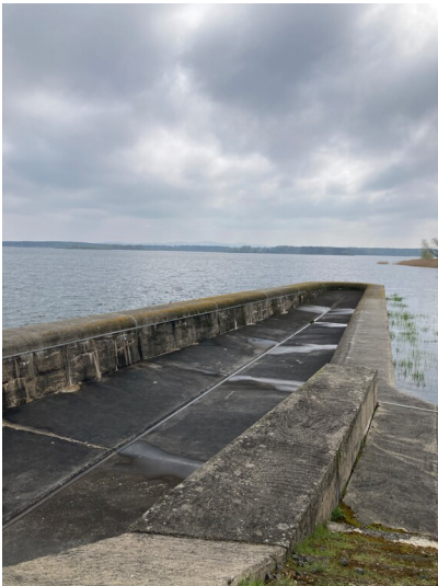
Talsperre Quitzdorf - Grundablassbauwerk Fotograf/Urheber: Kathrin Krüner
