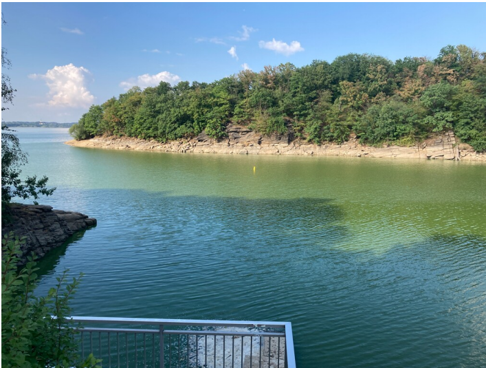
Talsperre Bautzen Fotograf/Urheber: Matin Neubacher
