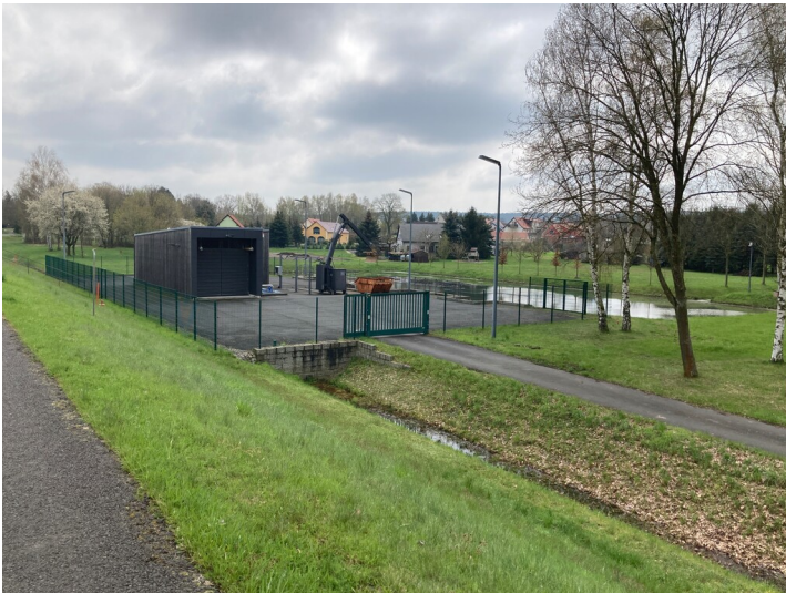
Schöpfwerk Quitzdorfer Stausee Fotograf/Urheber: Kathrin Krüner
