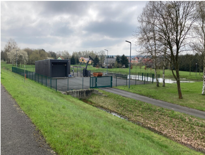
Schöpfwerk Quitzdorfer Stausee Fotograf/Urheber: Kathrin Krüner
